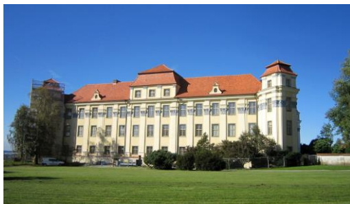
Schloss Tettngang mit neuem Verputz
